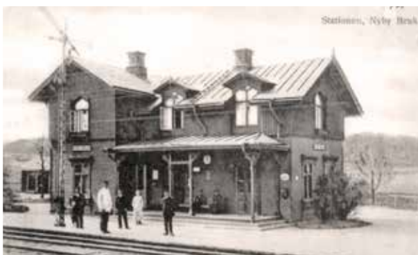
Järnvägsstation vid Nyby Bruk
