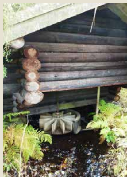
Exempel på restaurerad skvaltkvarn i Toftaån, Komstad by. (Foto: Länsstyrelsen Jönköpings län)
