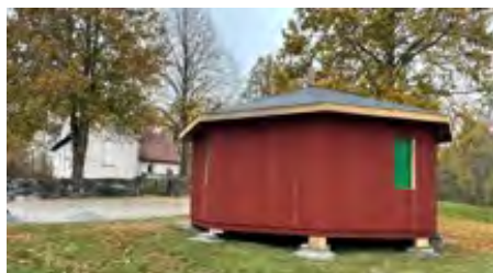
Paviljongen under byggnad
